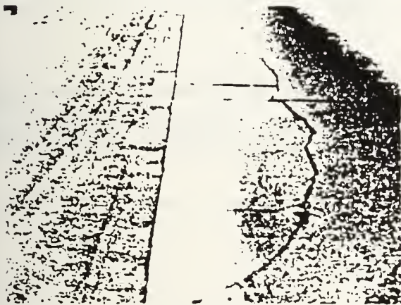
Fig. 3.2.4.7 — Edge crack
